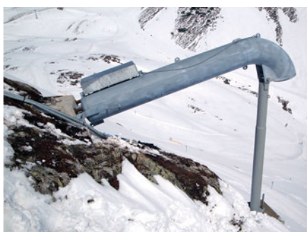
Gli esploditori Gazex sono azionabili con qualsiasi condizione meteo.
